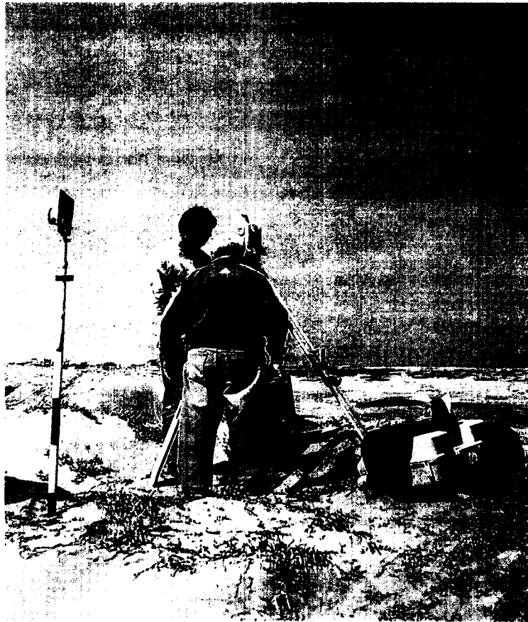
FOTO 08: Levantamiento Topográfico y batimétrico a cargo del especialista de FONDEPES Ing. William Zeballos
